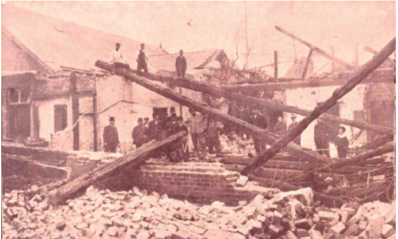
Die Brandruine des Wirtschaftsgebäudes von Friedrich Evers
