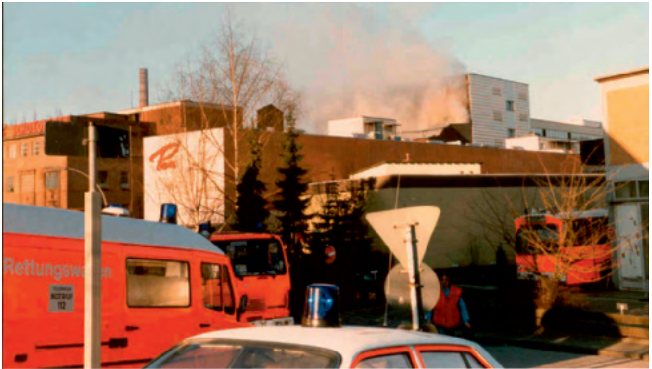
Die Einsatzstelle in Eppendorf am Morgen danach
